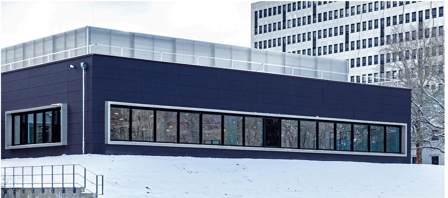
Das modulare Gebäude entspricht dem energetischen Standard Effizienzgebäude Bund 40. Die Wärmeversorgung erfolgt über Nahwärmenetz. Im Gebäude wird die Wärme über eine Fußbodenheizung verteilt. Eine Photovoltaikanlage auf dem Flachdach deckt einen Großteil des Strombedarfs aus erneuerbaren Energien.
