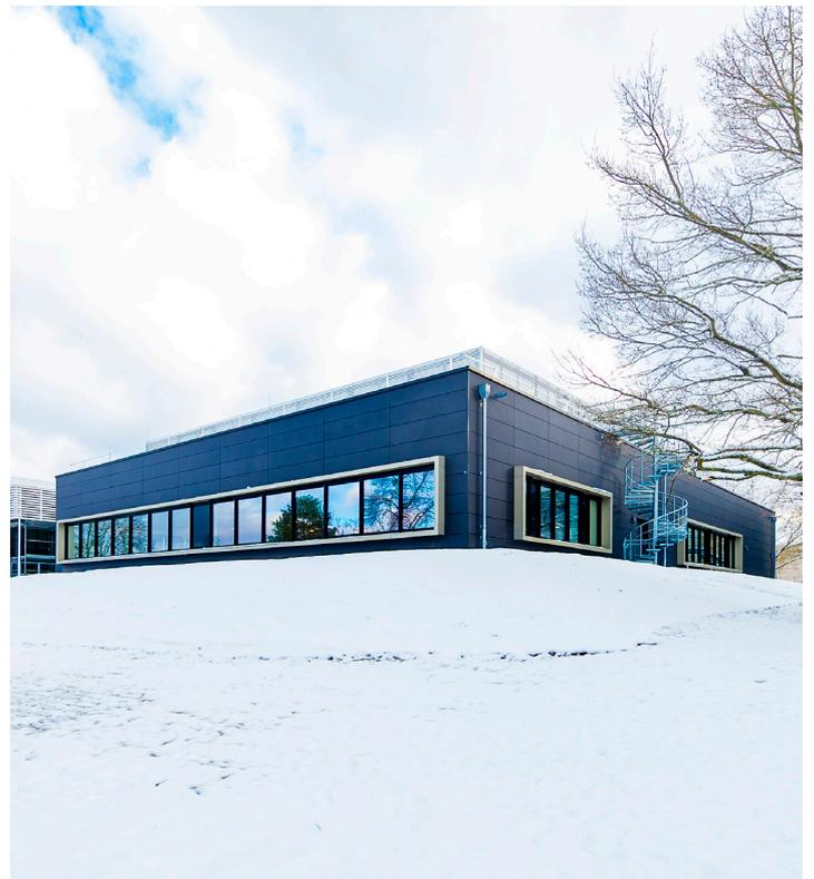
Der Verbindungsgang hat eine Pfosten-Riegel-Fassade mit bodentiefer Verglasung. Um diese transparente Optik nicht einzuschränken, wurde eine Fußboden- und Deckenheizung eingebaut.
